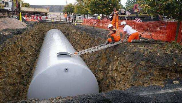
Réserve métallique enterrée
